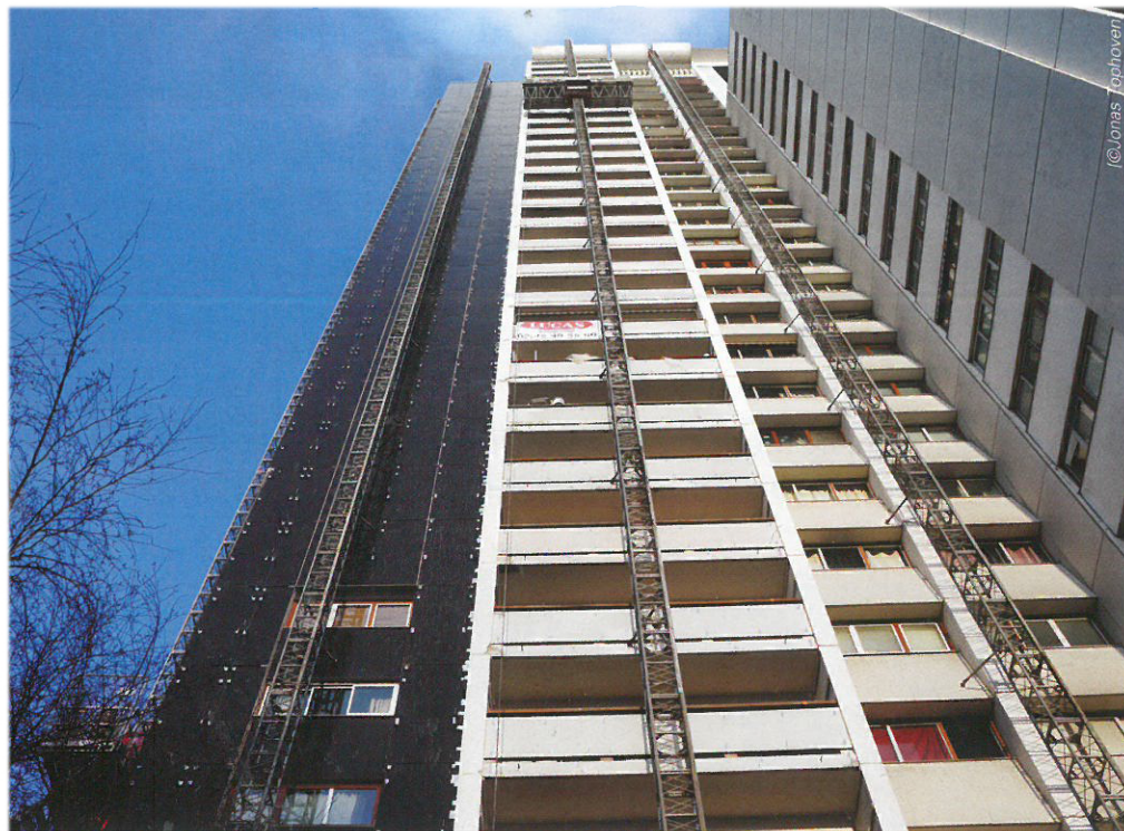
Façade Est en attente de la mise en œuvre de l'ITE.
