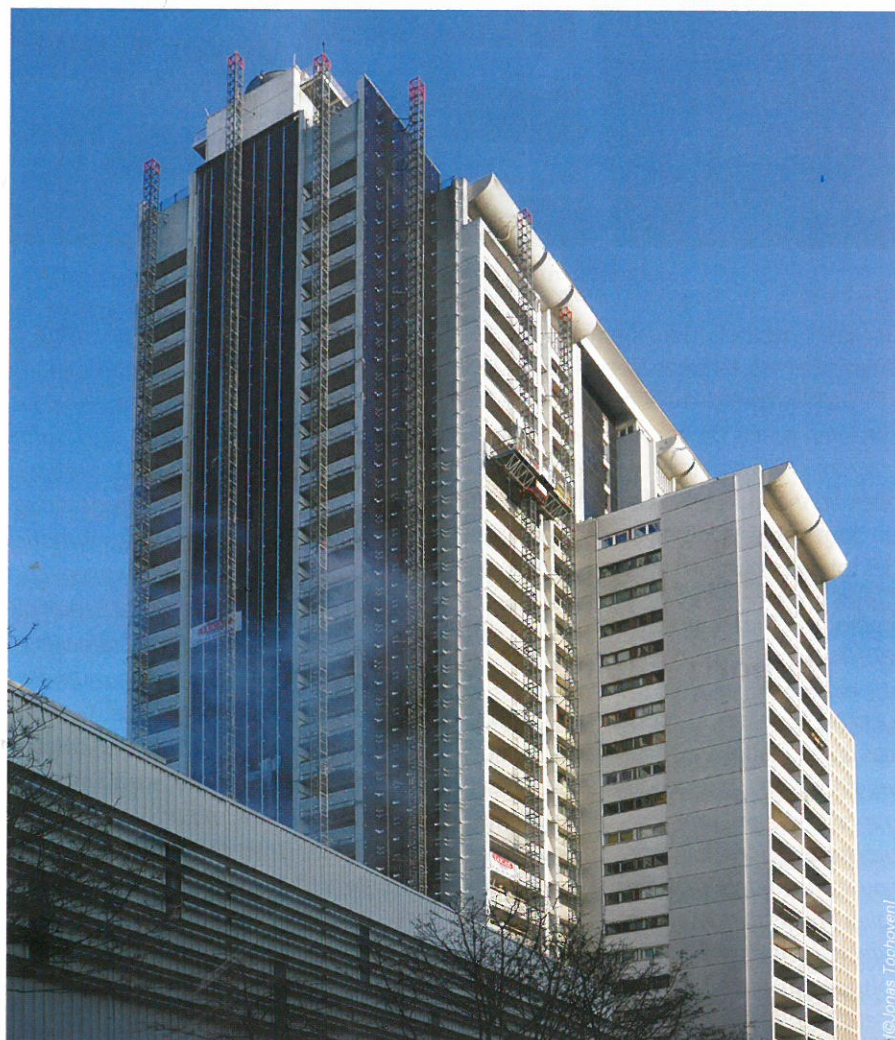
La rénovation énergétique de l'immeuble Super-Montparnasse fait date par la taille et la configuration du chantier.
