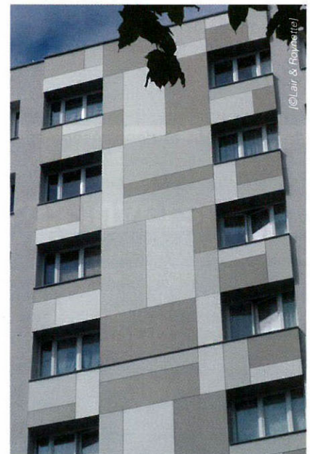
Le remplacement de l'ensemble des fenêtres et baies vitrées (ici la façade Nord-Ouest) s'accompagne de la mise en œuvre de volets roulants. Ces derniers, par leurs qualités d'étanchéité, participent à la réduction des déperditions thermiques.
